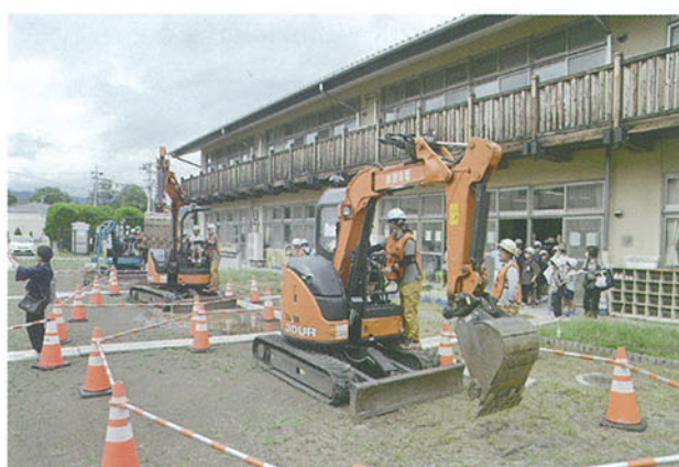
重機操作は大人気で列が絶えなかった
