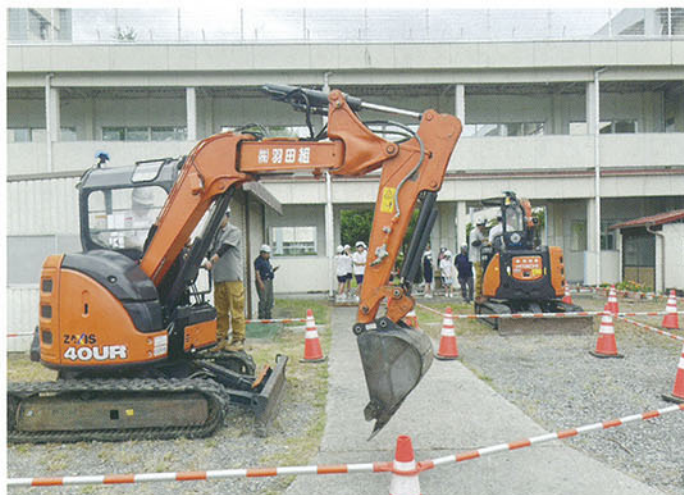
バックホーを慎重に操作する
