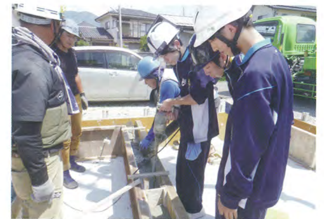
コンクリート打設に挑戦
