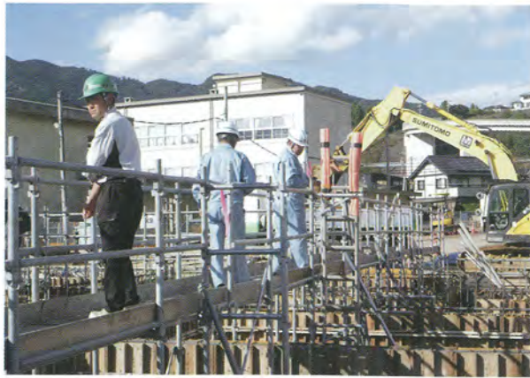
改築事業が進む上田第五中学校
