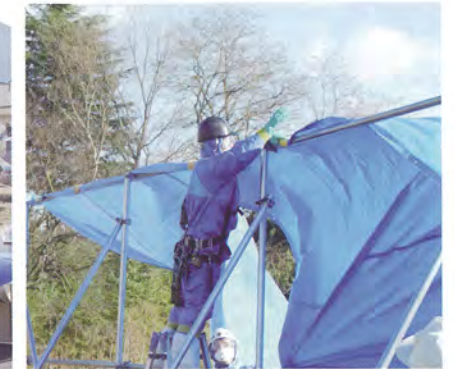
目隠しフェンスの設置
