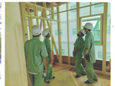
建築中の家屋の内部
