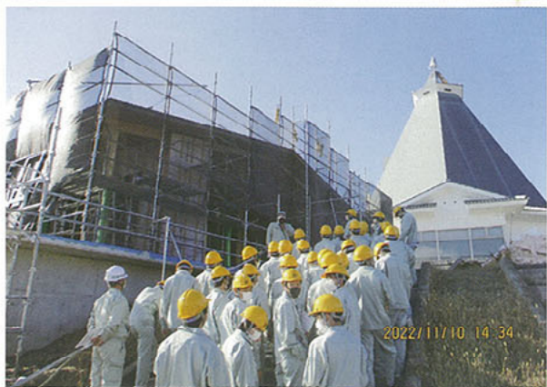
建設中の「スタラス小諸」
