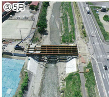
⑤5月 ⑤工場で製作されていた橋(上部工)が到着
