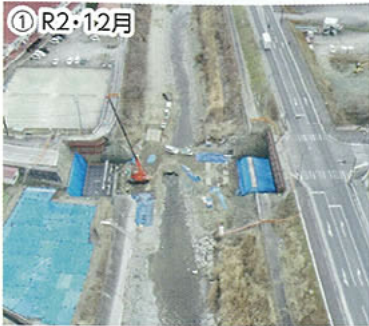
① R2・12月 ①、②橋台の設置工事が進む。コンクリートが凍みないよう、打設後は周囲を囲い、温度管理を行う
