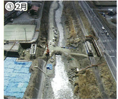
③2月 ③出来上がった部分の橋台が埋め戻される
