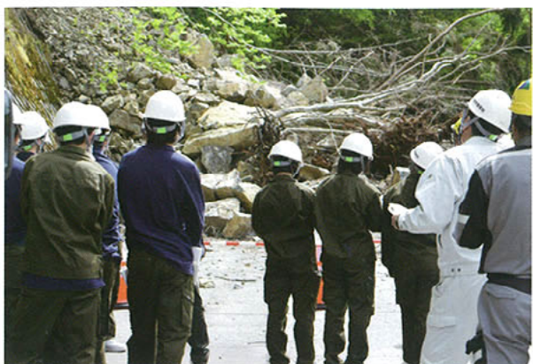
崩落現場を間近で見学した
