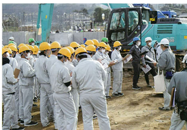
新小学校の工事の様子を確認
