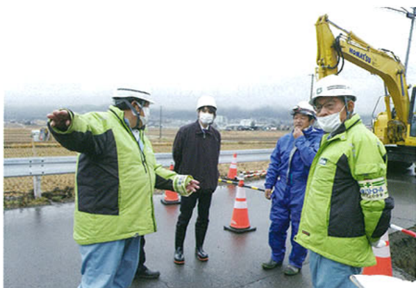
担当者と安全状況の確認を行った
