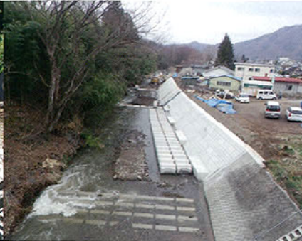
戸沢橋下(神川) / 千曲建設工業株式会社
