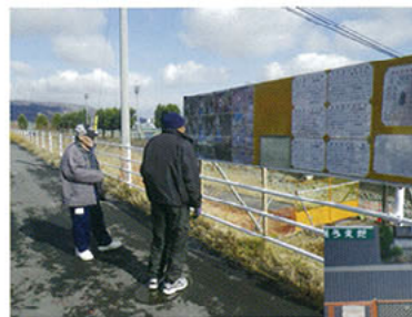
掲示板の進捗写真に「だいぶできてきたね」
