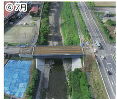
⑥7月 ⑥床版の施工が進む
