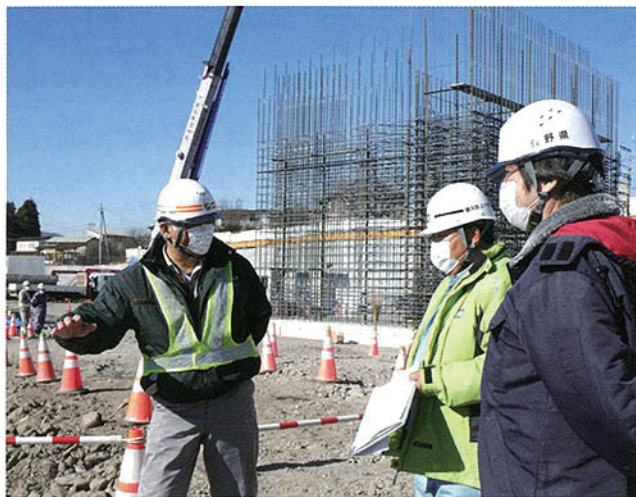
工事概要の説明を受ける
