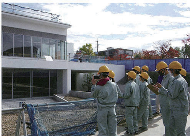
工事の進捗を確認(信濃美術館)
