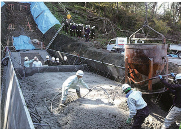
生コン打設作業を間近で(大日向)
