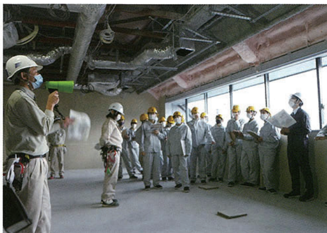
天井内部の説明を聞く(上田市新庁舎)
