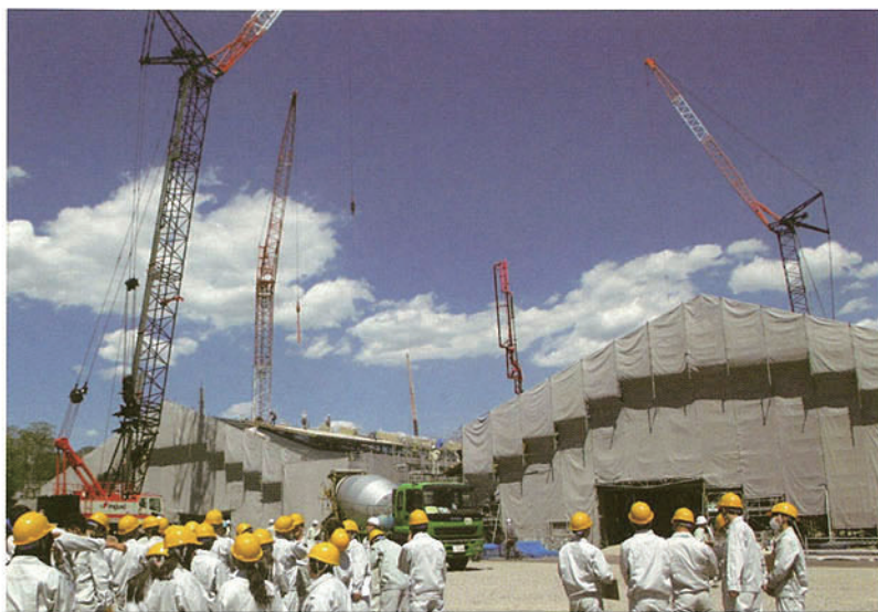
県立武道館の建設現場
