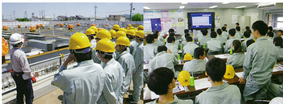
千曲市の新庁舎建設現場
