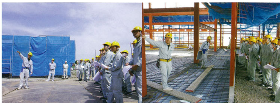
上田市の神川統合保育園・地区公民館の現場
